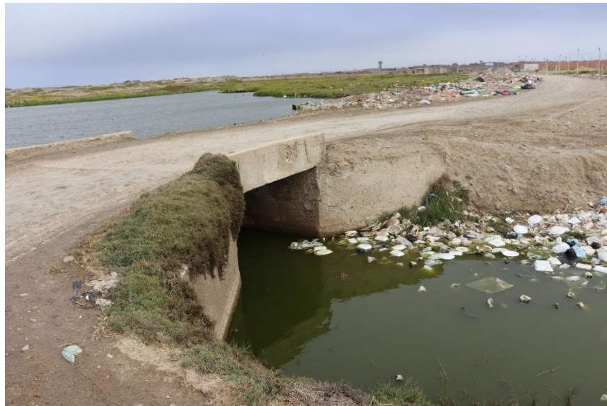
Fig.3 Puente del Canal
