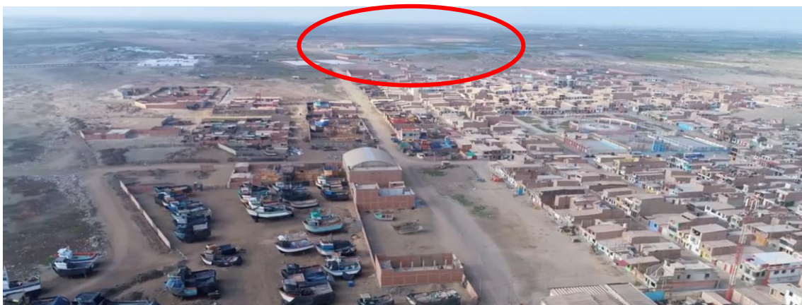
Ilustración 7: Vista Aérea Sur a Norte de la Ubicación del Humedal
