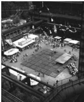
Nota: Vista de Plaza Metálica centro emblemático del conjunto. Fuente: libro "El dialogo ético en el Proyecto Sostenible"
