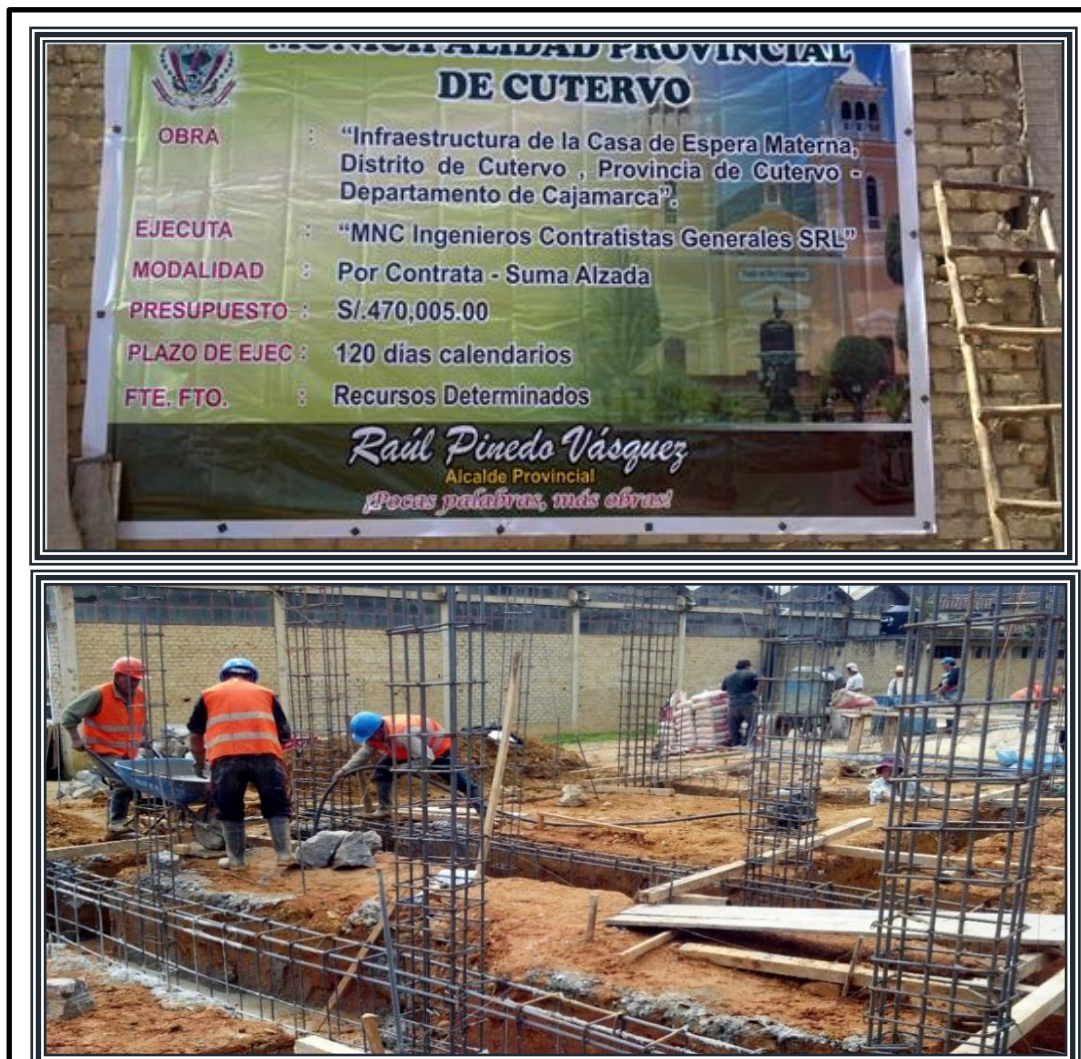
Figura 15: Fotos de obra
