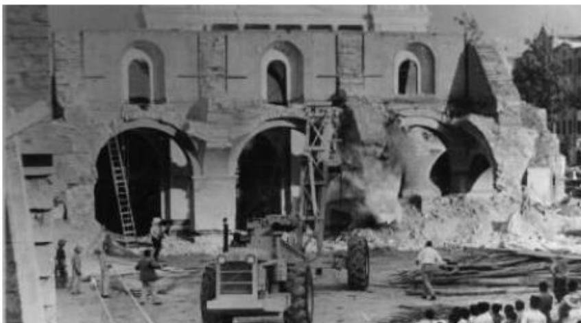
Imagen 17. Demolición de la Iglesia Matriz 1960
