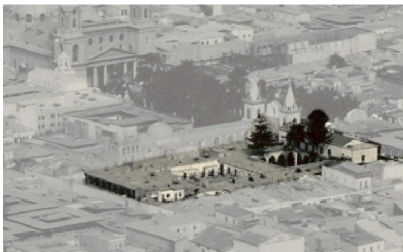
Imagen 30. Vista posterior del ex convento antes de la intervención de 1940.
