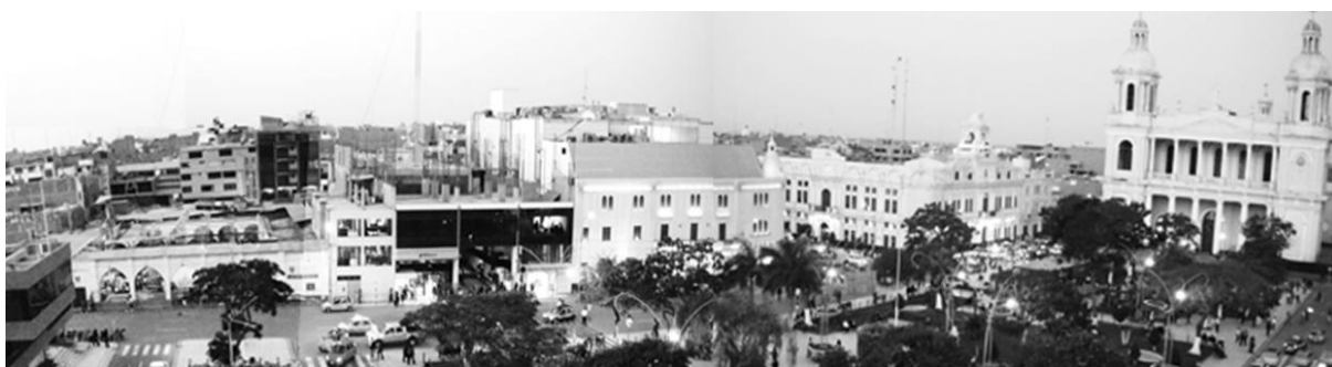
Imagen 26. Entorno de monumento desde Edificio Atlas
