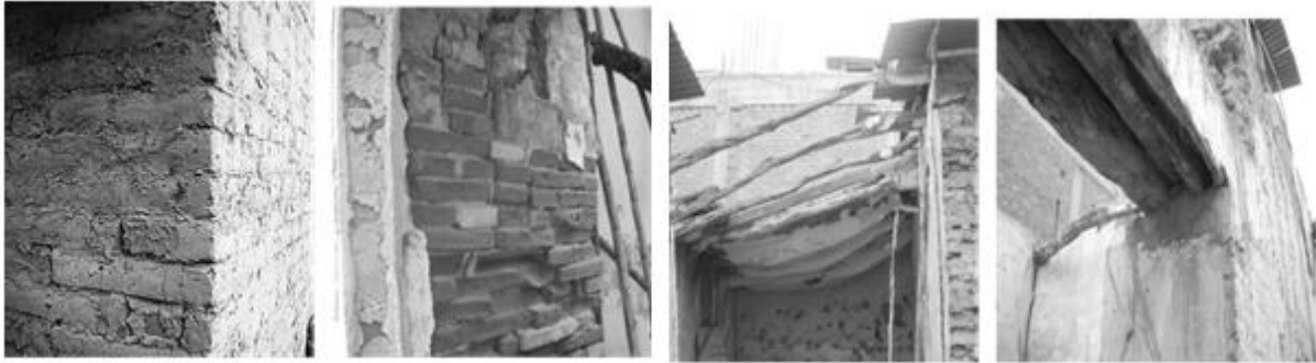
Imagen 37. Selección de fotos – Detalles estructuras
