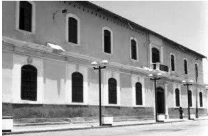
Imagen 22. Vista de la fachada completa en la avenida Bolognesi.
