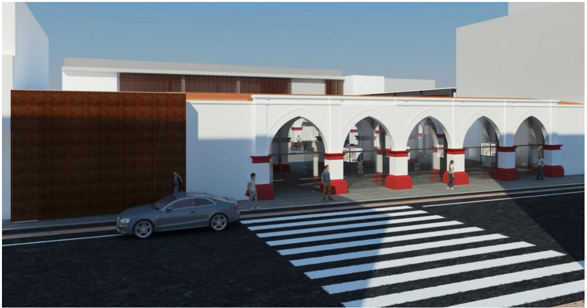
Imagen 41. Fachada principal del monumento intervenido – calle San José
