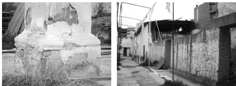
Imagen 38. Selección de fotos – Revestimientos en muros
