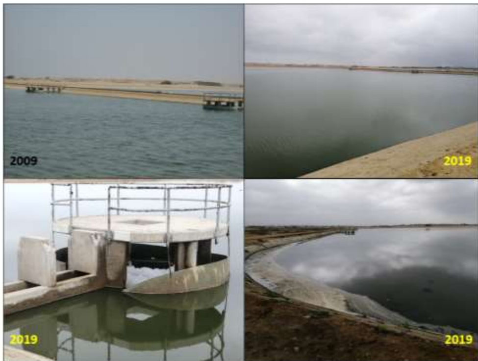
Figura 15: Lagunas Aeróbicas.
