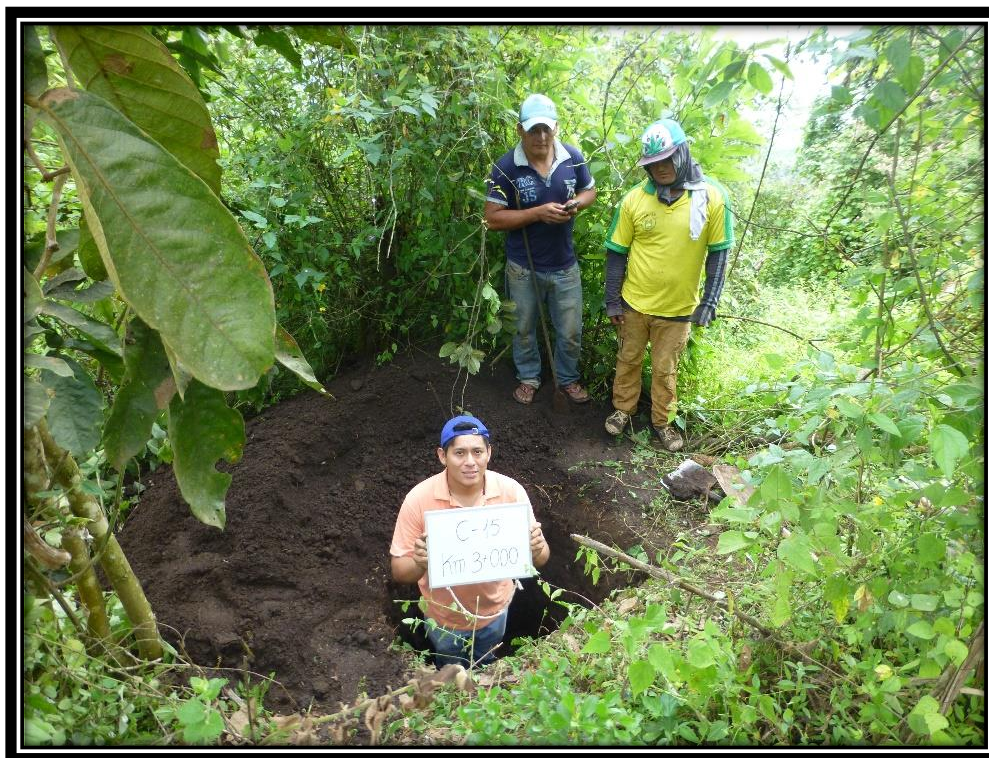
Fotografía N° 55: Excavación de la calicata N° 15
