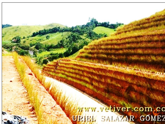
Fotografía N° 20: Talud con vetiver en carretera
