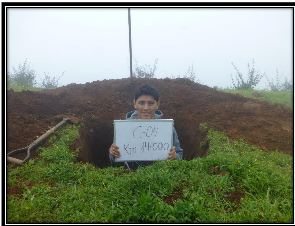
Fotografía N° 53: Excavación de la calicata N° 4
