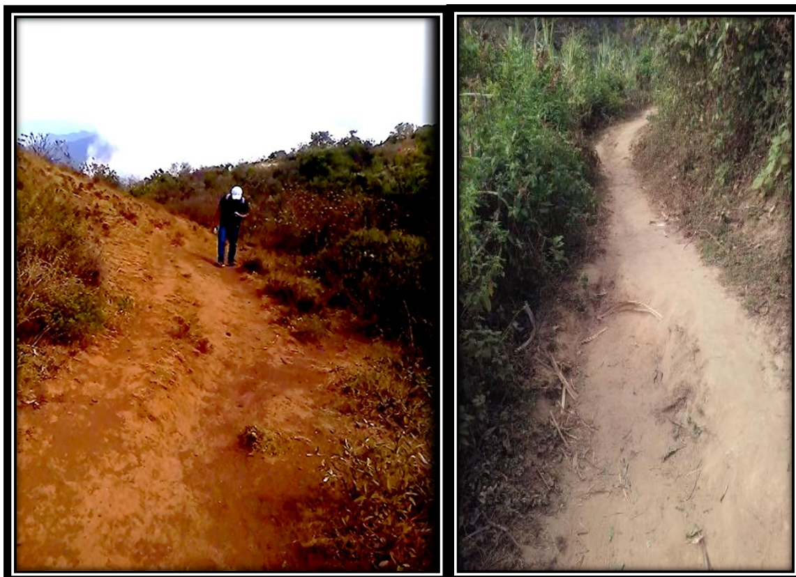
Fotografía N° 39: Caminos de herradura del tramo El Marco –Andamarca
