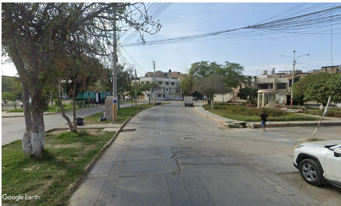
Figura 28: ANTES - Av. Libertad – Urb. Federico Villareal (Fuente propia)
