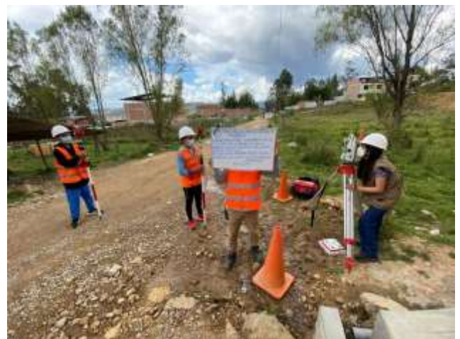
Figura 158: Trabajo de campo con estación total
