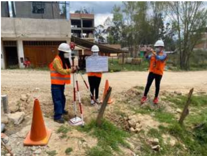
Figura 155: Trabajo de campo con estación total
