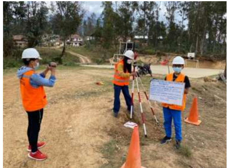
Figura 154: Trabajo de campo con estación total
