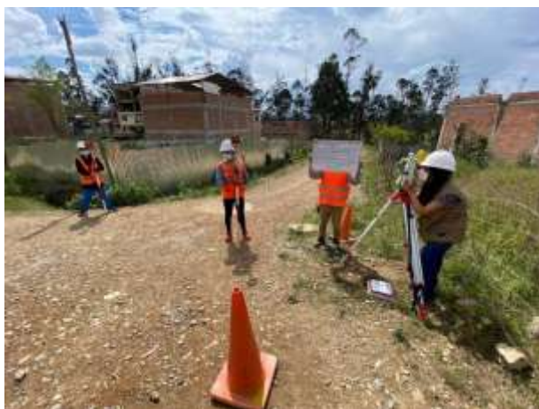
Figura 157: Trabajo de campo con estación total
