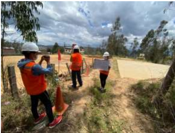
Figura 153: Trabajo de campo con estación total
