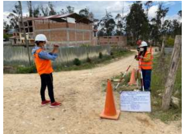
Figura 152: Trabajo de campo con estación total
