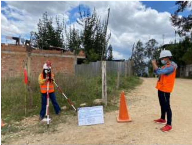
Figura 151: Trabajo de campo con estación total
