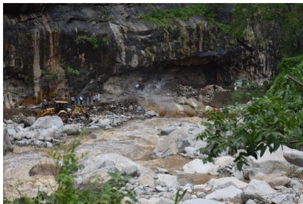
Figura 1 Carretera derrumbada por el Rio la Leche
