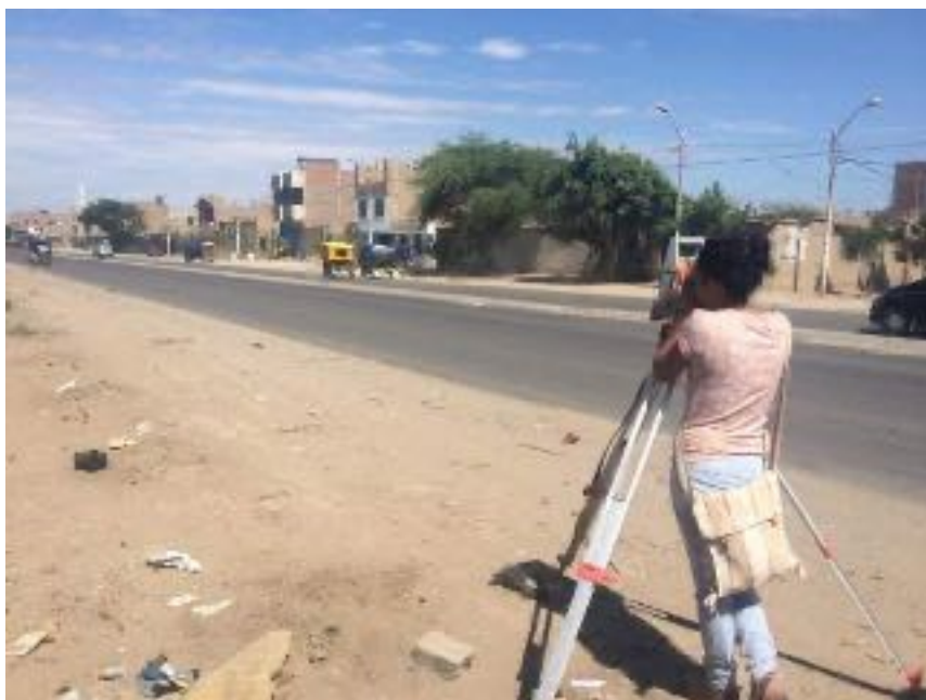
Figura 2.3 Vista panorámica del terreno.
