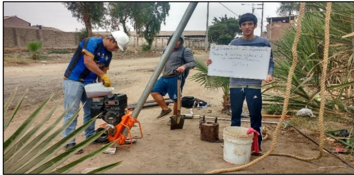
FOTOGRAFÍA 4. 1 Identificación del sondeo Spt N°02
