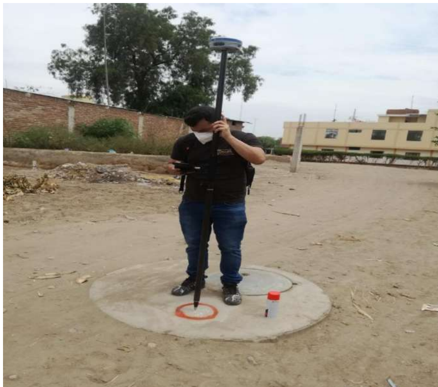
Fotografía 10 Toma de puntos en buzones de desague
