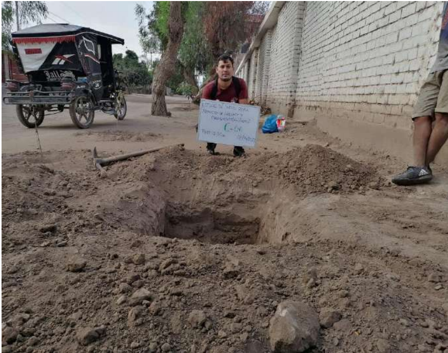
Fotografía 5 Calicata N° 06 en la Ca. Calle M
