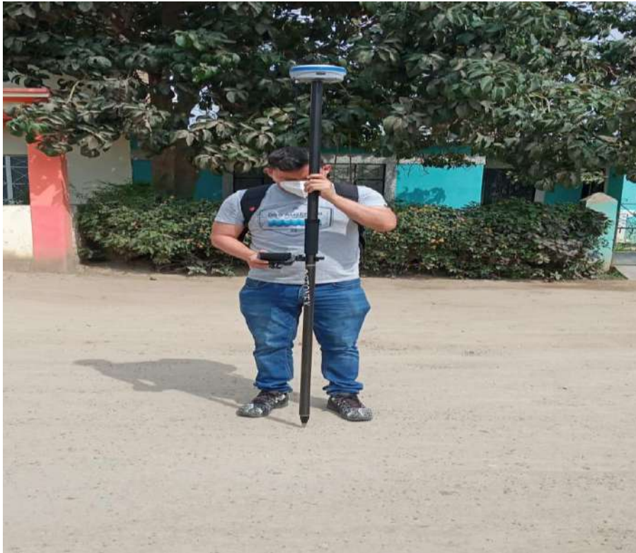
Fotografía 9 Toma de punto en eje de Vial
