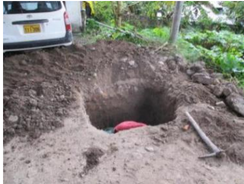
FIGURA 20. Excavación de la calicata N° 02
