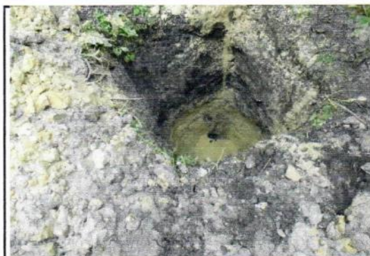
DESCRIPCION FOTO N°: EXCAVACION CULMINADA EN CALICATA 01. 3
