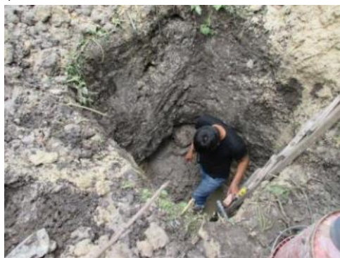
FIGURA 24. Toma de la muestra de la calicata N° 03
