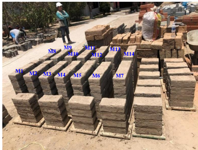
Figure 14 Muretes expuestos al secado
