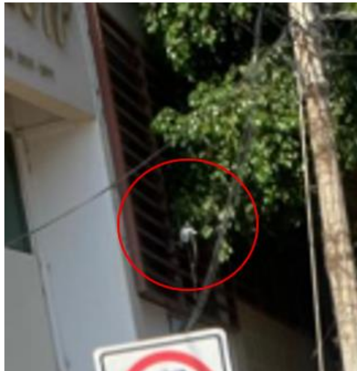
FIG. 30: CÁMARA INSTALADA EN FACHADA DEL CLUB DE TIRO
