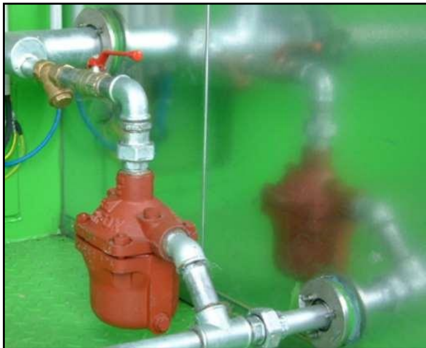
Figura 18: Filtro por cajas purgadoras automáticas.
