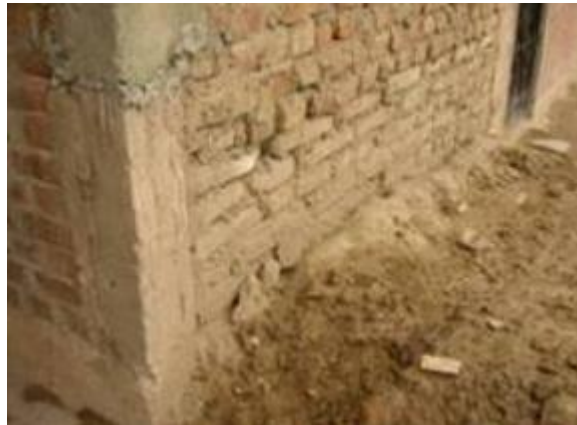
Fig. 3 Muros constituidos por ladrillos y adobe
