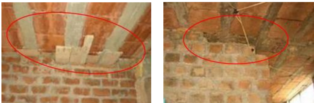
Fig. 4 En la unión muro, viga, techo relleno con ladrillos
