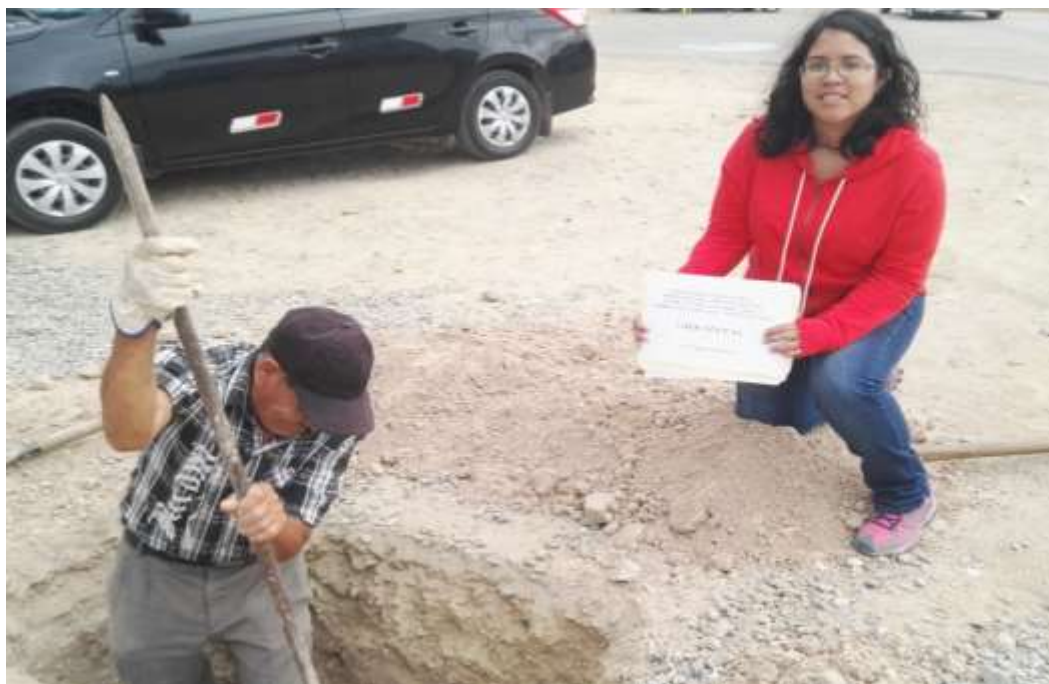
Imagen N°30: Excavación de calicata N° 01.
