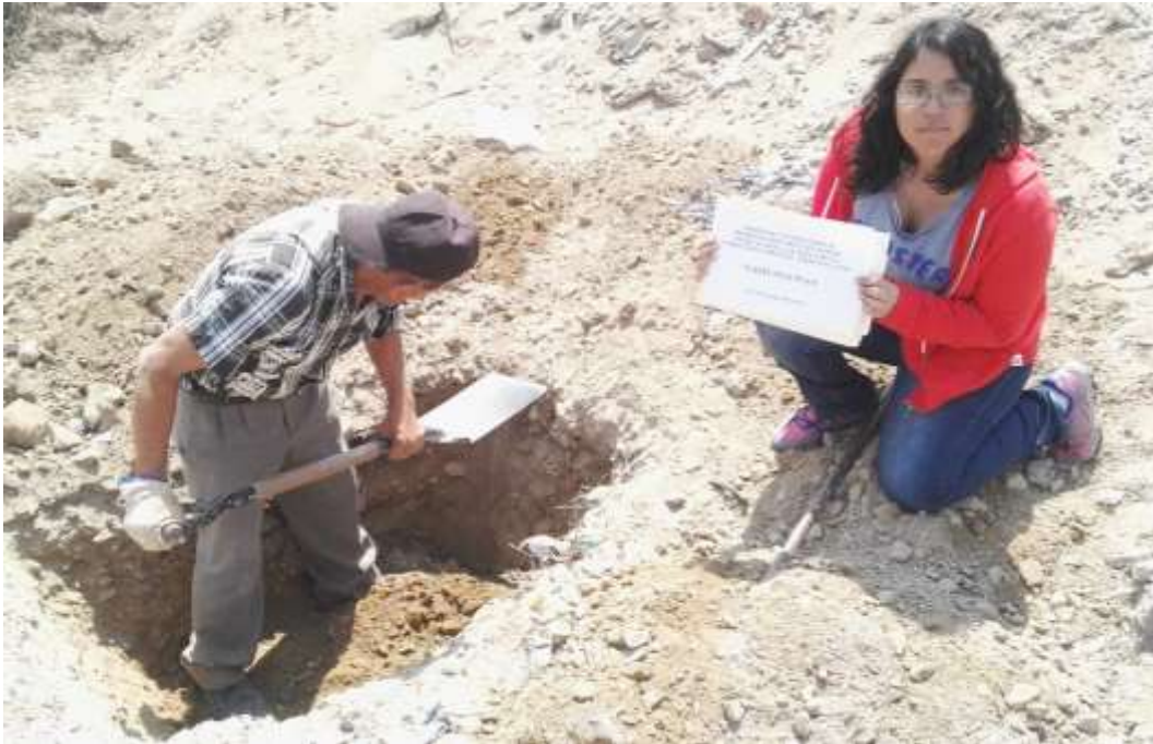
Imagen N°32: Excavación de calicata N° 02.
