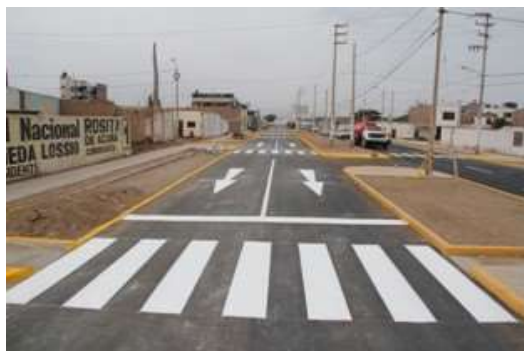
Imagen N°02: Ejemplo de marcas en el pavimento en una carretera.
