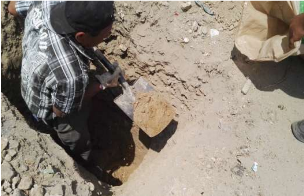
Imagen N°34: Obtención de muestra de calicata N° 02.
