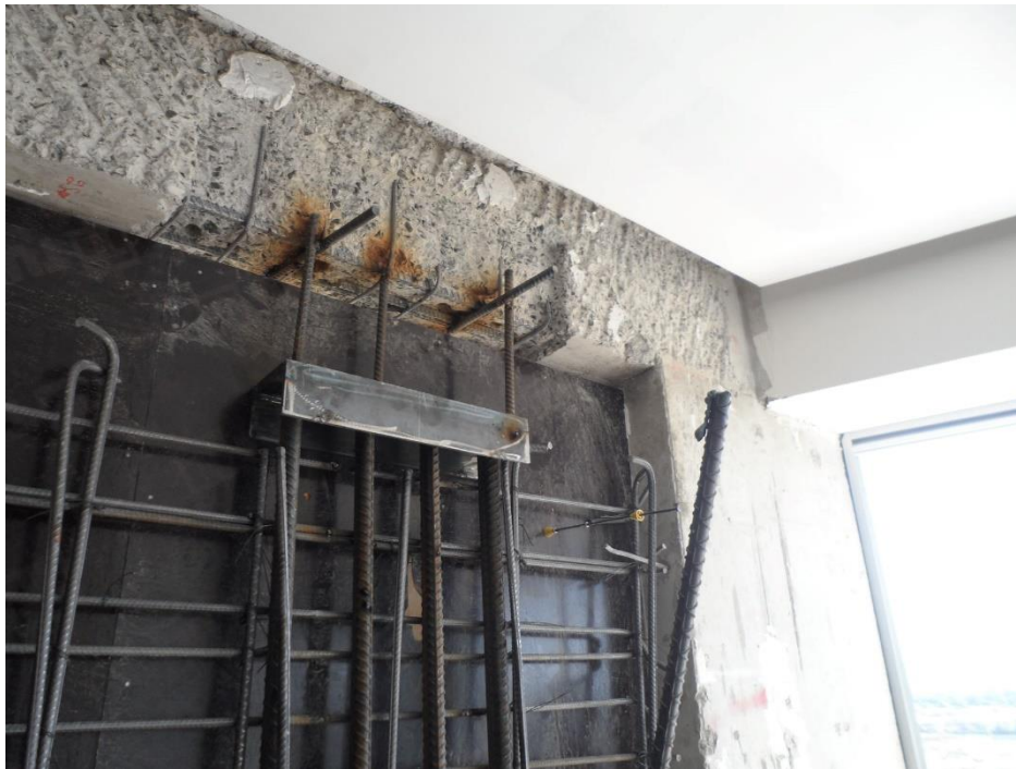
Figura 32: Habilitación de acero y base metálica para disipador SLB en muro desacoplado [30].
