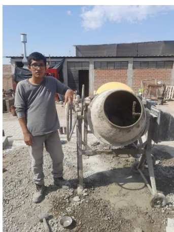
Figura 82: Elaboración de concreto en mezcladora
