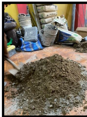
Ilustración 35: Mezcla de arena cernida con cemento
