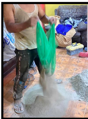
Ilustración 9: Proceso de tamizado manual realizado por un obrero. Fuente: Imagen tomada de una construcción domiciliaria en Chiclayo.
