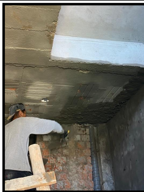
Ilustración 38: Tarrajeo de paredes, techo, etc. con la arena cernida
