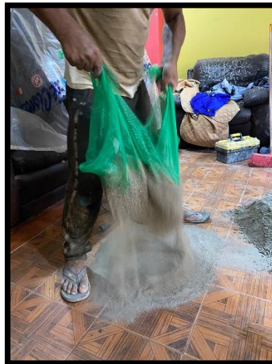
Ilustración 33: Proceso de tamizado manual de arena
