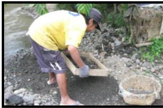
Ilustración 3: Personal de obra cerniendo a brazos con zaranda.
