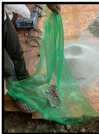
Ilustración 34: Residuos que quedan de la arena cernida
