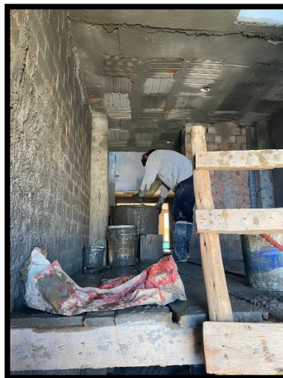
Ilustración 37: Arena cernida y mezclada lista para usarla en el tarrajeo.
