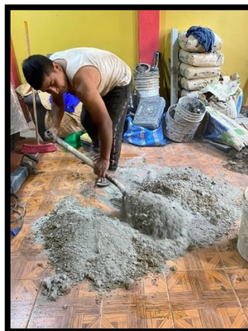
Ilustración 36: Mezcla de arena cernida con cemento
