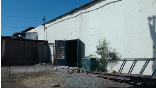
Figura 33. Vista de zona exterior - Estado actual. Fuente: Elaboración propia.
