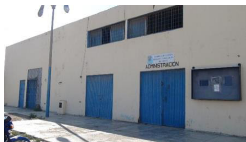
Figura 31. Vista exterior de zona alquilada - Estado actual. Fuente: Elaboración propia.
