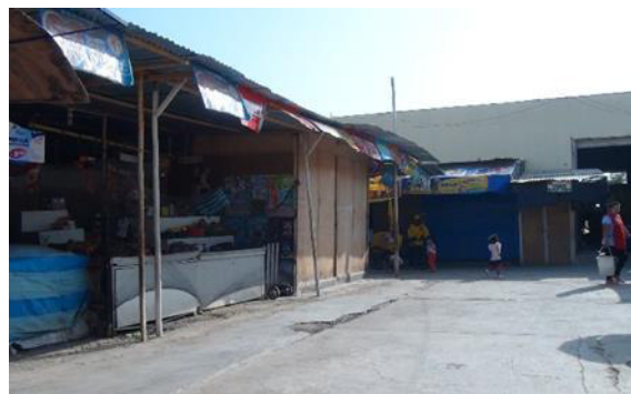
Figura 28. Vista de patio de zona comercial - Estado actual. Fuente: Elaboración propia.
