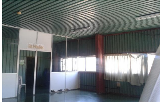
Figura 26. Vista interior de zona administrativa - Estado actual. Fuente: Elaboración propia.
