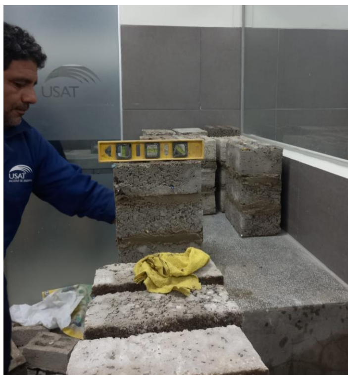
Ilustración 28 Elaboración de las pilas de tres hiladas, controlada por un nivel para verificar la verticalidad.
