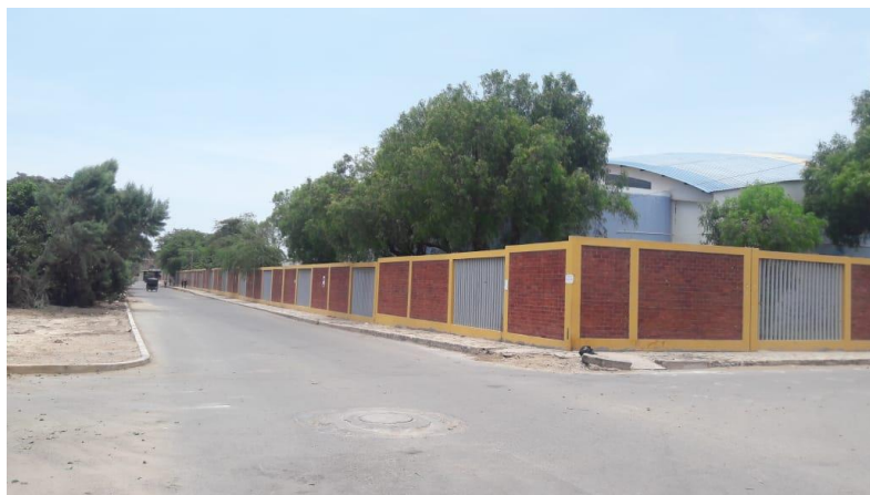
Figura 2 Registro fotográfico- Lado sur-este del complejo deportivo
