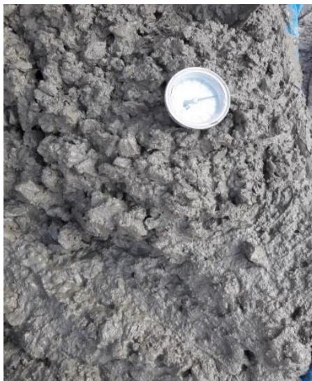
Figura 22: Determinación de la temperatura de mezcla de hormigón
