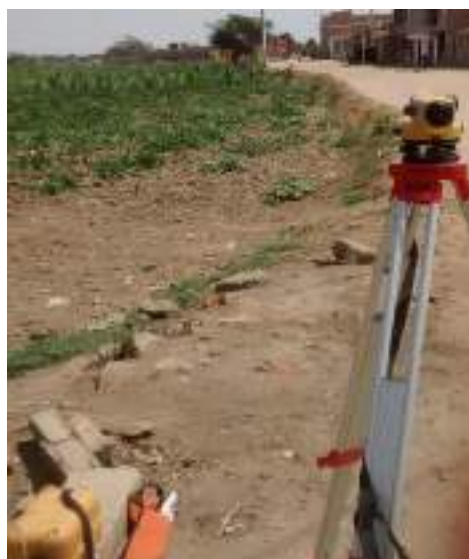
Ilustración 3 Levantamiento topográfico para relleno
