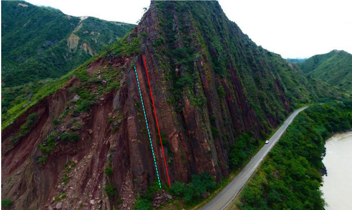
Imagen 3. Continuidad línea roja, del plano de discontinuidad marcado de rojo
