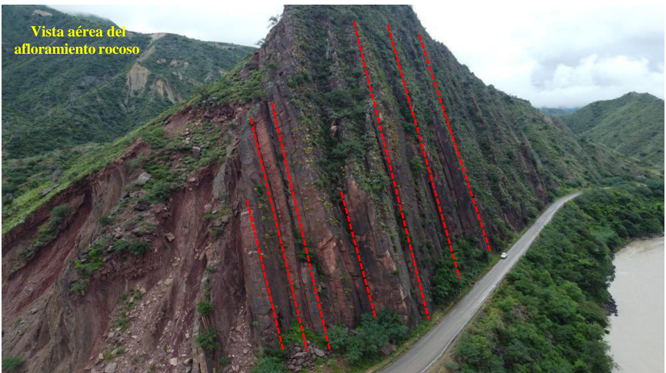
Ilustración 34. vista aérea, fuente propia.
