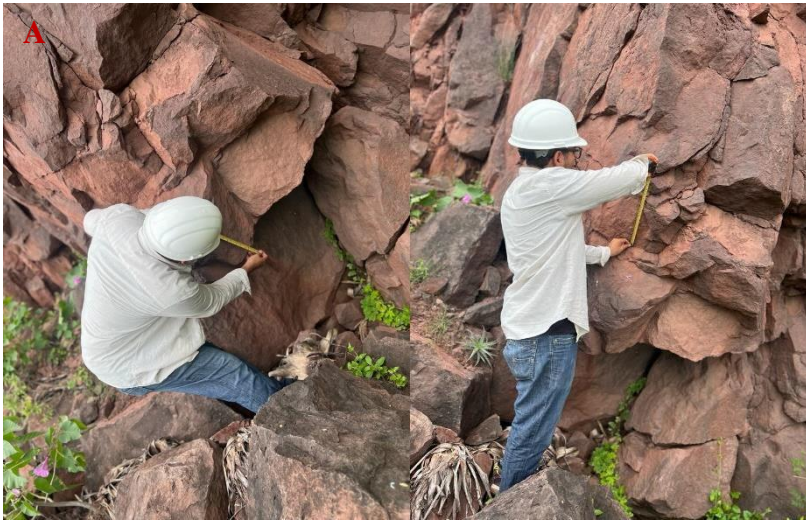
Ilustración 33 Espaciamiento de discontinuidades
