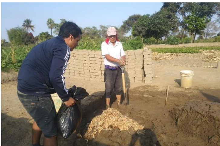
Anexo 60: Colocación de fibra de enea
