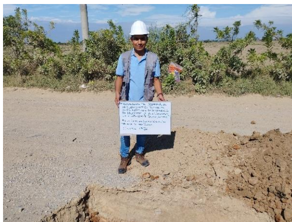
Ilustración 11: Calicata N°3 – extracción de muestra
