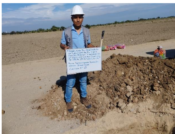
Ilustración 10: Calicata N°2 – extracción de muestra
