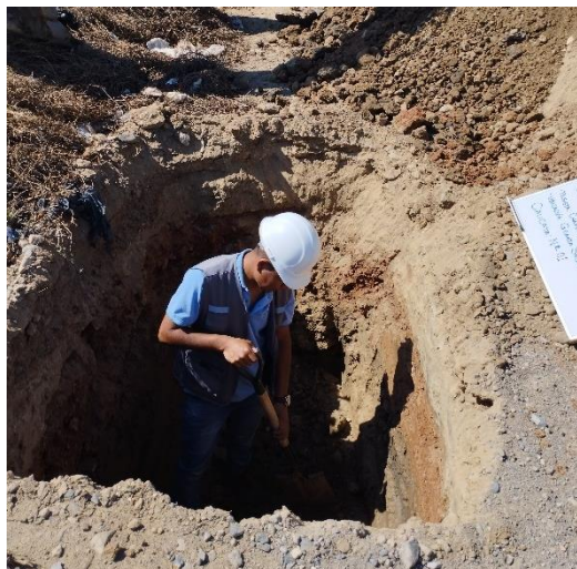
Ilustración 9: Calicata N°1 – extracción de muestra
