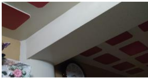
Encuentro viga columna
