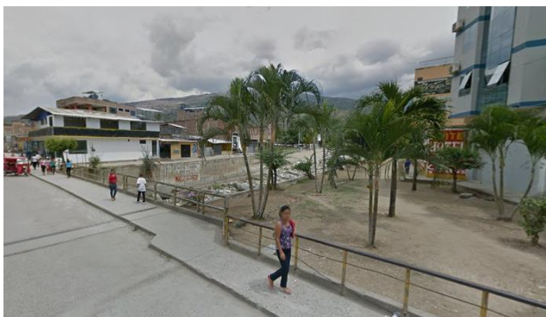
Imagen 42: El espacio ribereño degradado de Jaén. Fotografía del tramo del puente Villanueva pinillos. Fuente: propia
