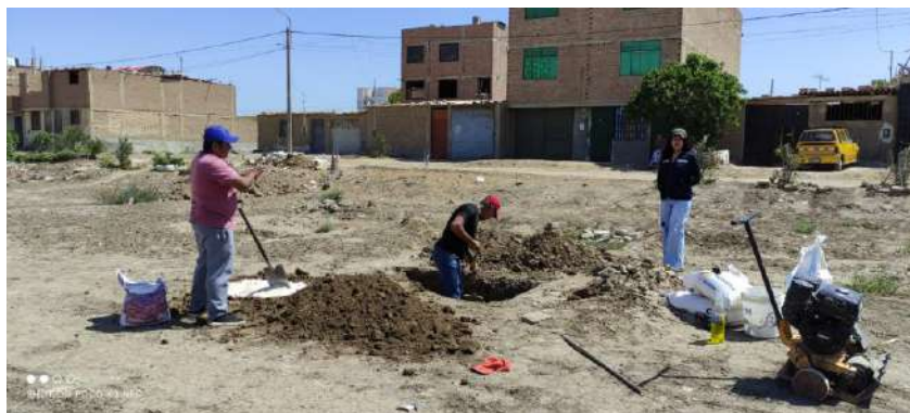
Figura 60. Desarrollo del tramo experimental: excavación y batido de mezcla
