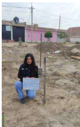
Figura 61. Ensayo DCP en el tramo experimental
