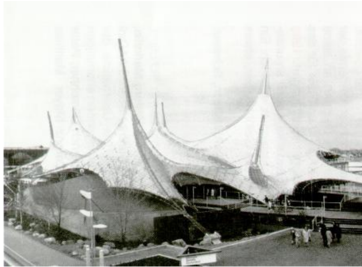
Fuente: Otto Frei, Cubiertas colgantes . 1962
