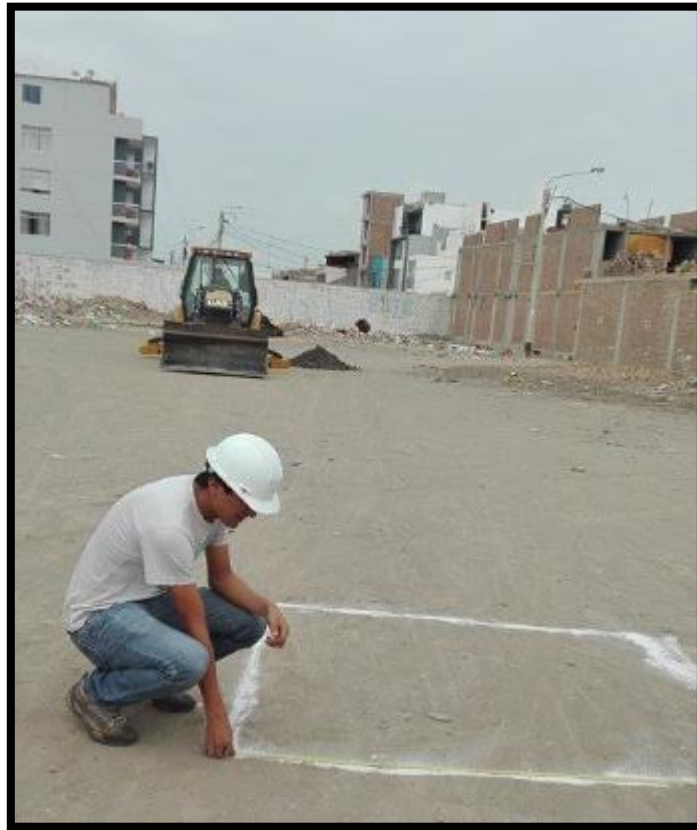
Imagen N° 43 Delimitación de la calicata a excavar
