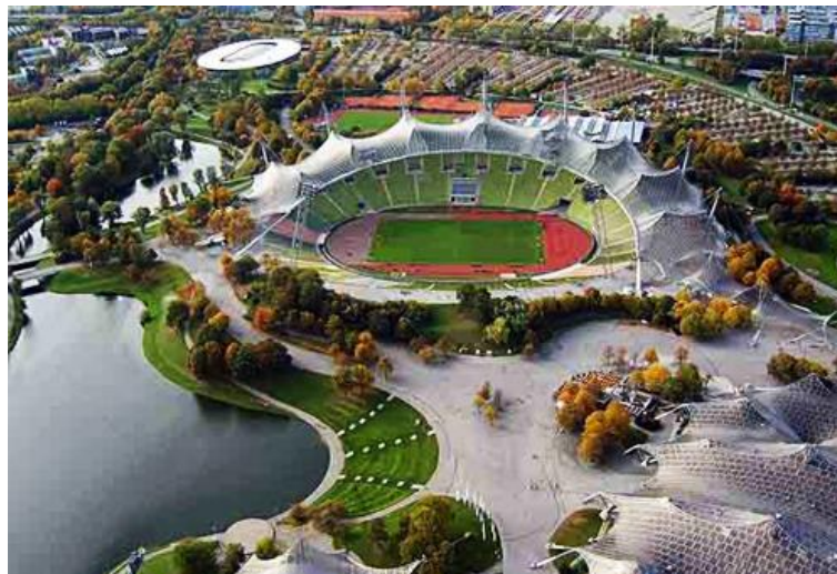
Fuente: Otto Frei, Cubiertas colgantes . 1962
