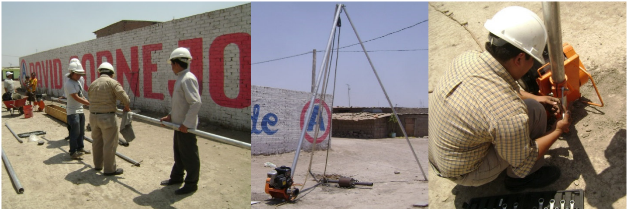
Fotografías N° 02. Instalación del trípode del SPT.
