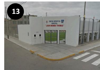
Centro Deportivo Municipal "Juan Hende Thomas"
