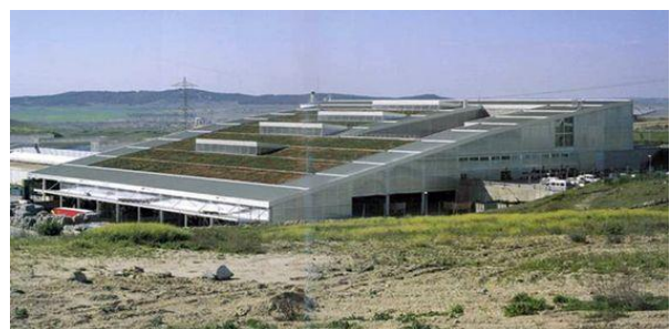
GRÁFICO 39: Vista del centro de Reciclaje Las Dehesas
