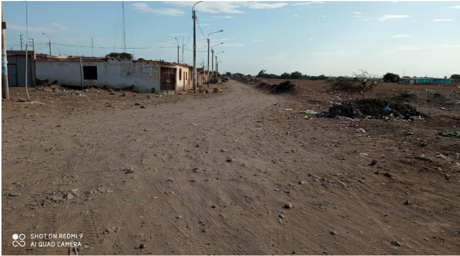
Imagen 1. Fotografías de la zona de proyecto
