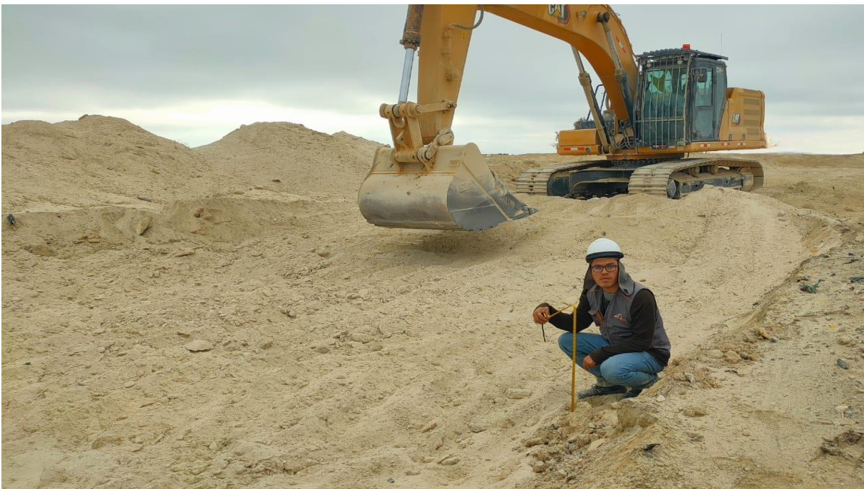
Figura 64. Medición con flexómetro los 30cm de espesor tratado de subrasante
