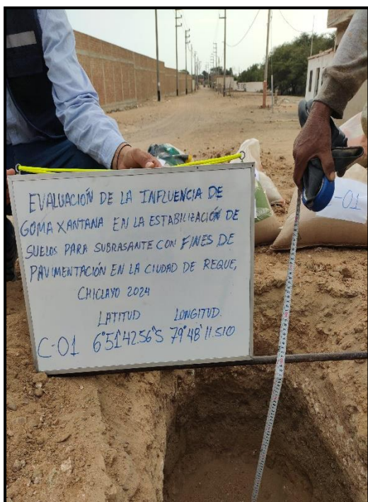
Figura 38. Extracción muestra C-01
