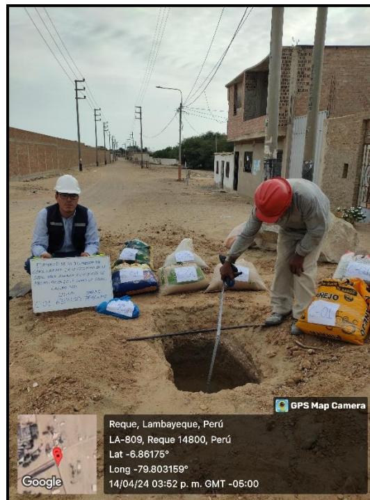
Figura 39. Extracción muestra C-01
