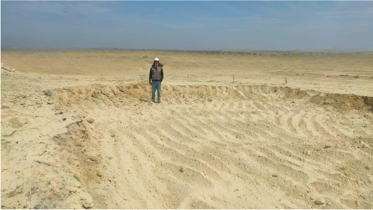
Figura 63. Inicio de excavación del tramo de prueba de 40m de largo por un ancho de vía 6m
