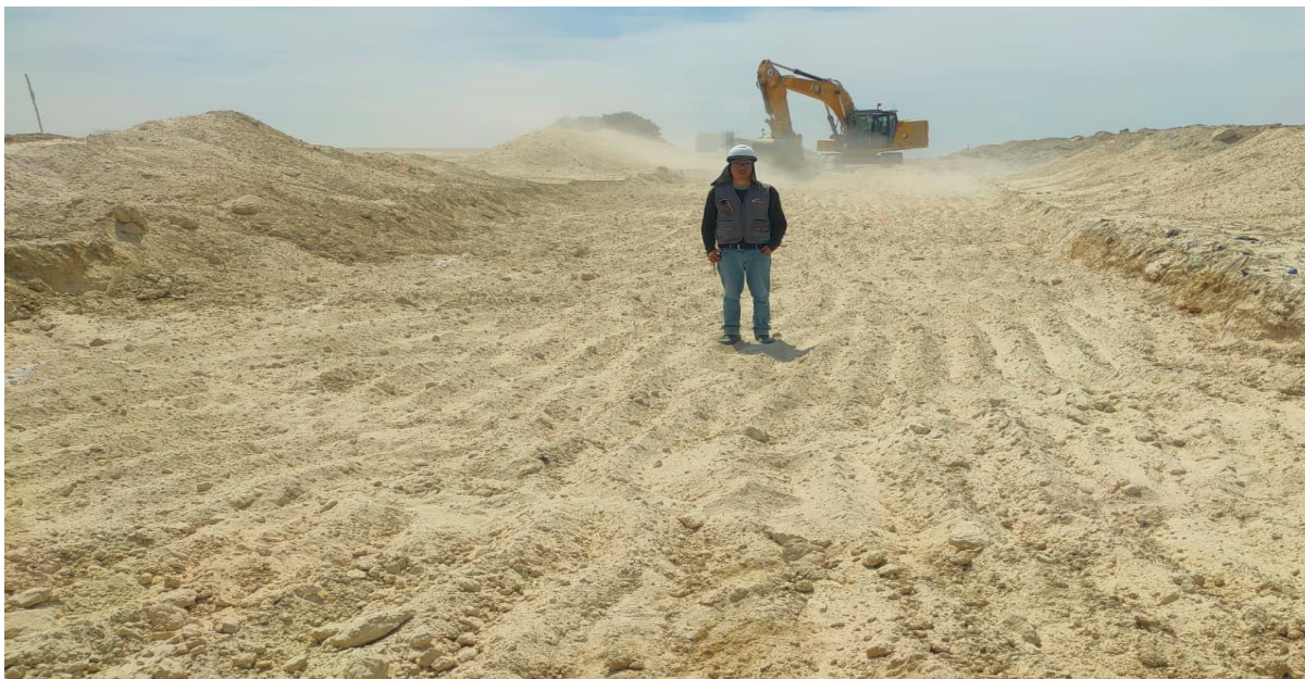
Figura 32. Excavación del tramo de prueba con excavadora
