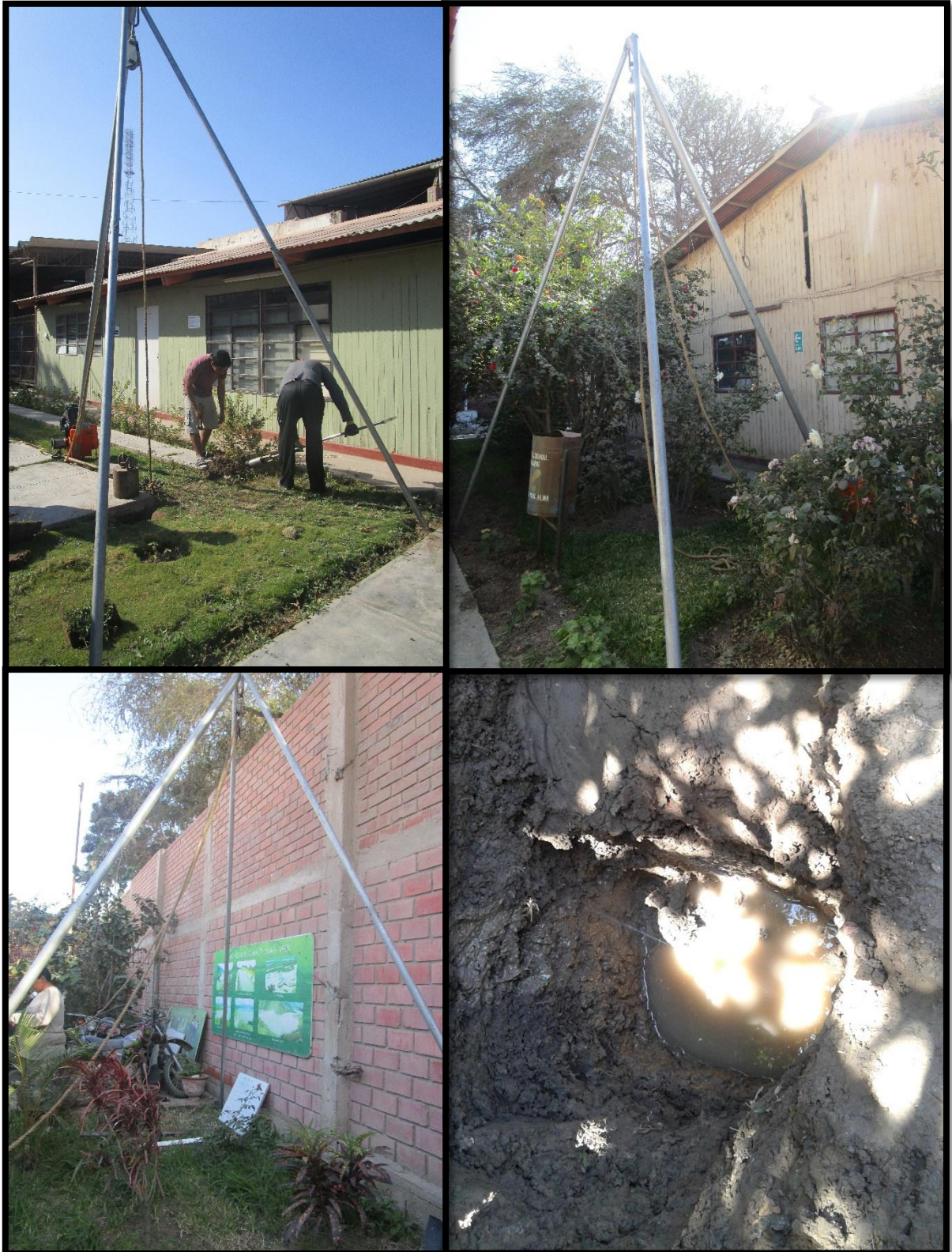
FOTOGRAFÍA N°2.2: Zona de Estudio y Vista de la Ubicación de los puntos de SPT y calicatas.
