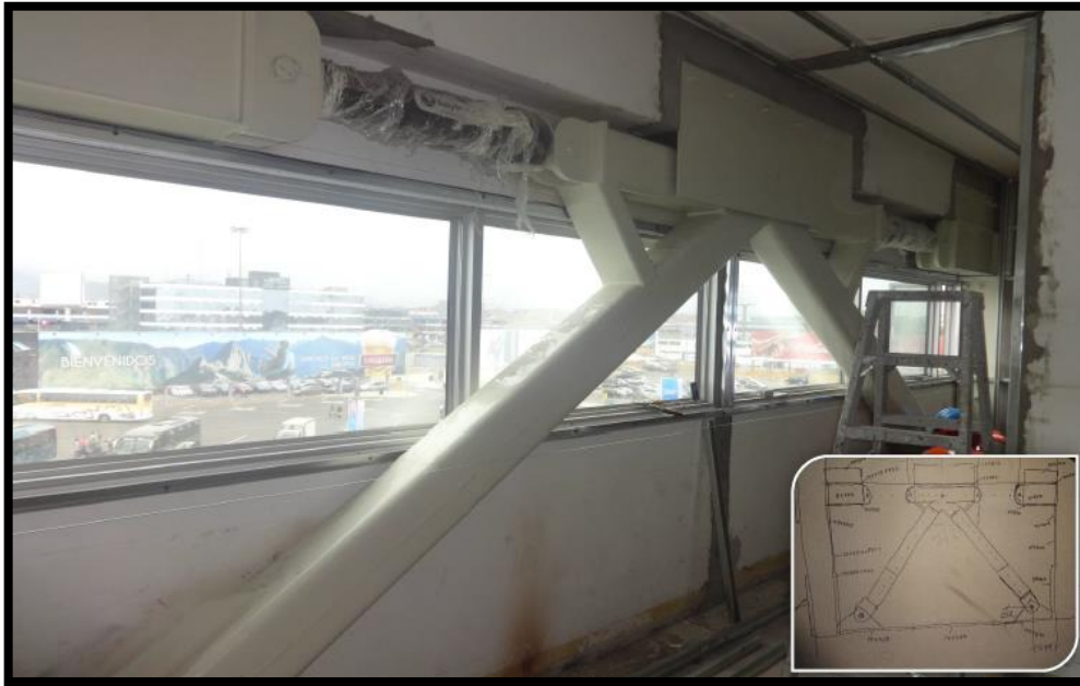
Figura 7: Verificación de las dimensiones de los disipadores en obra
