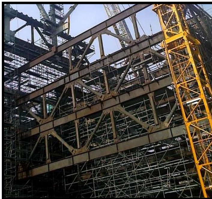
Fuente: Propia. Centro de Convecciones de Lima – Supervisión CESEL INGENIEROS S.A. (Julio, 2015)
