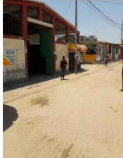
Ilustración 6. Calles principales en mal estado.
