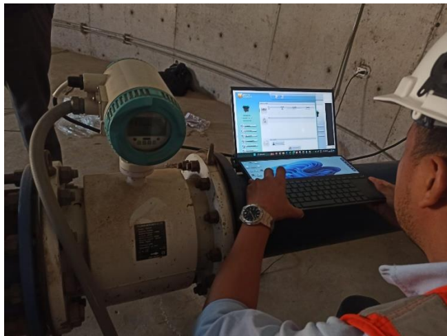
Fig. 70: Finalización de la Instalación de Datalogger, Mocupe tradicional 2024.
