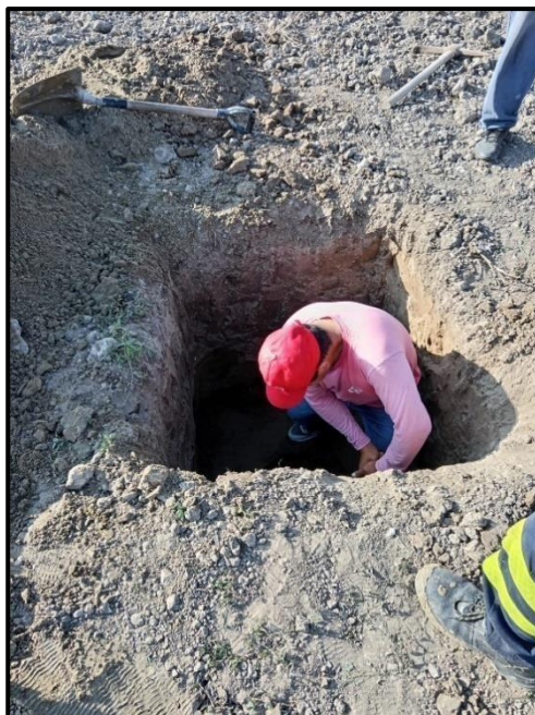
Imagen XV Excavación de Calicata 03 – Fuente propia
