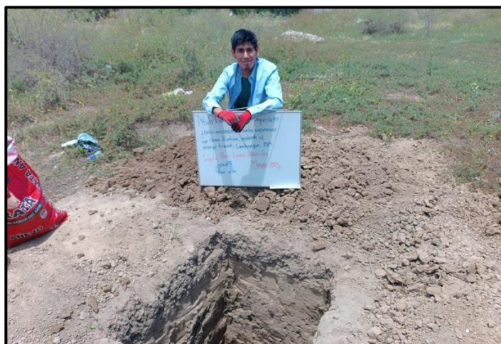
Imagen XIII Punto de excavación 01 – Fuente propia
