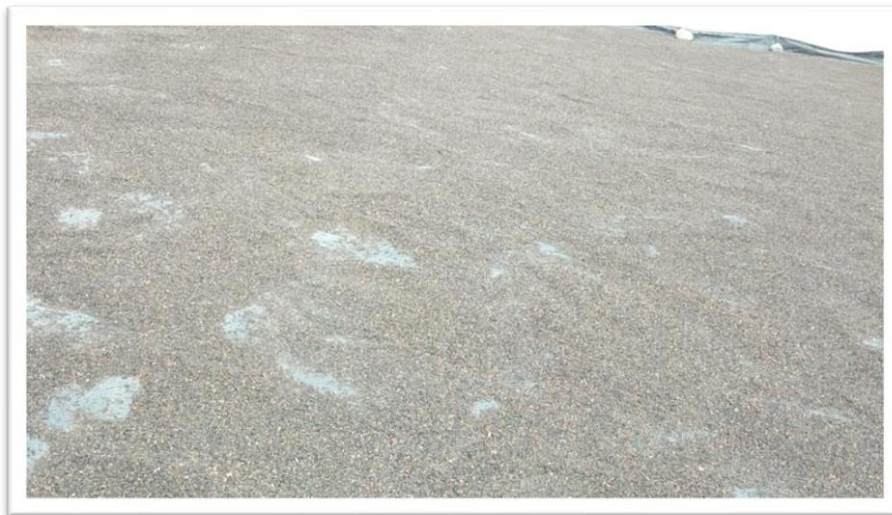
Figura 11. 1era. Etapa de tendido de MP.
