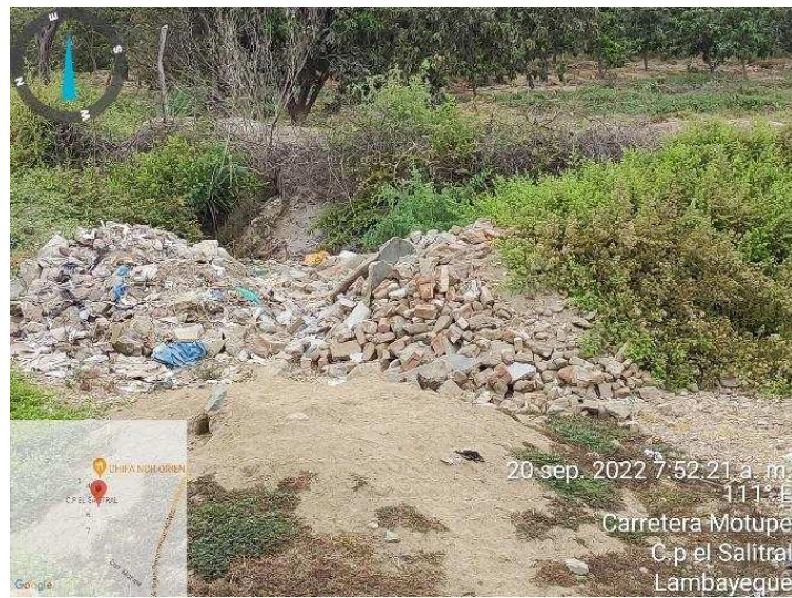
Fotografía 4: Situación actual en RCD – MOT 01
