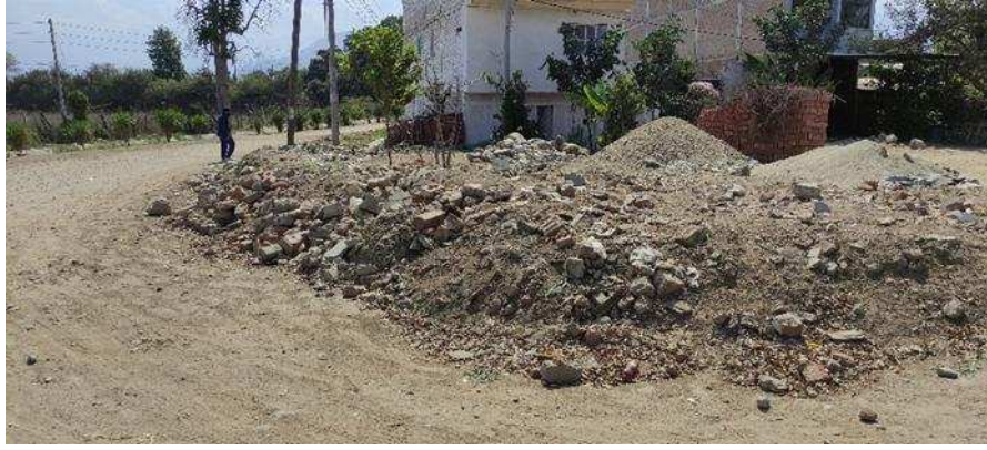
Fotografía 16: Situación actual en RCD – MOT 13
