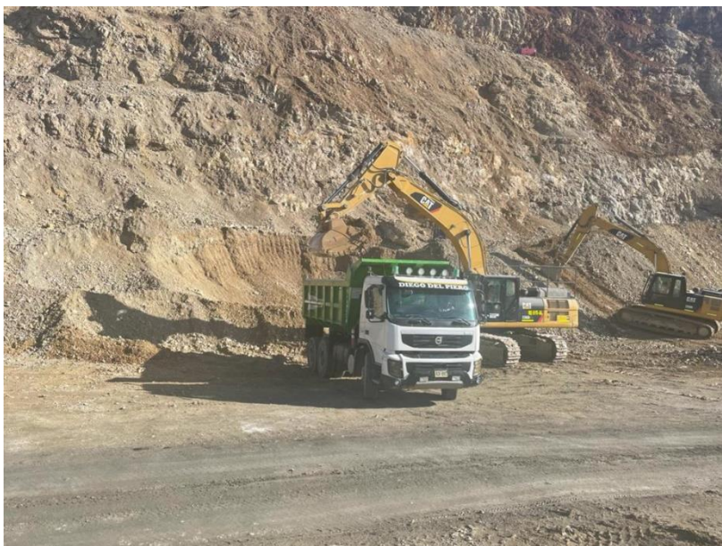
Figura 5. Carguío de material por excavadora.
