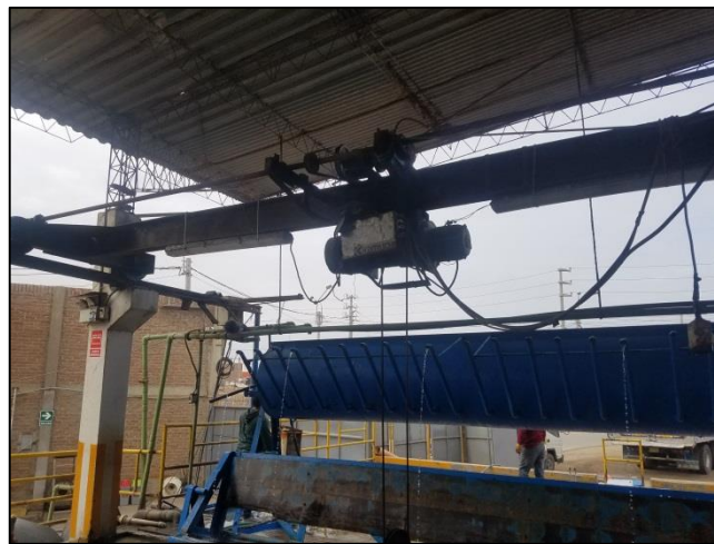
Figura 12. Reblase de agua en la cisterna
