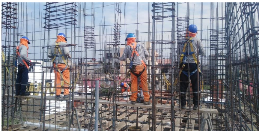
Figura 82: Trabajo Productivo en la partida de Acero Muros de Corte
