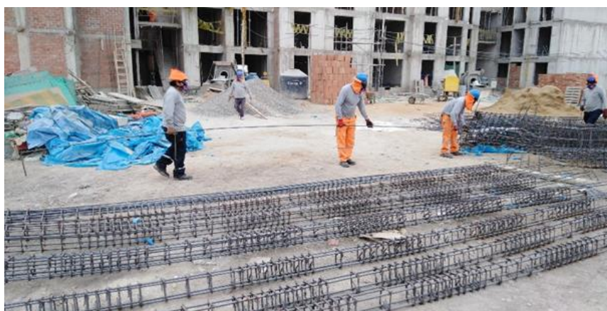
Figura 94: Trabajo Contributorio en la partida de Acero Columnas
