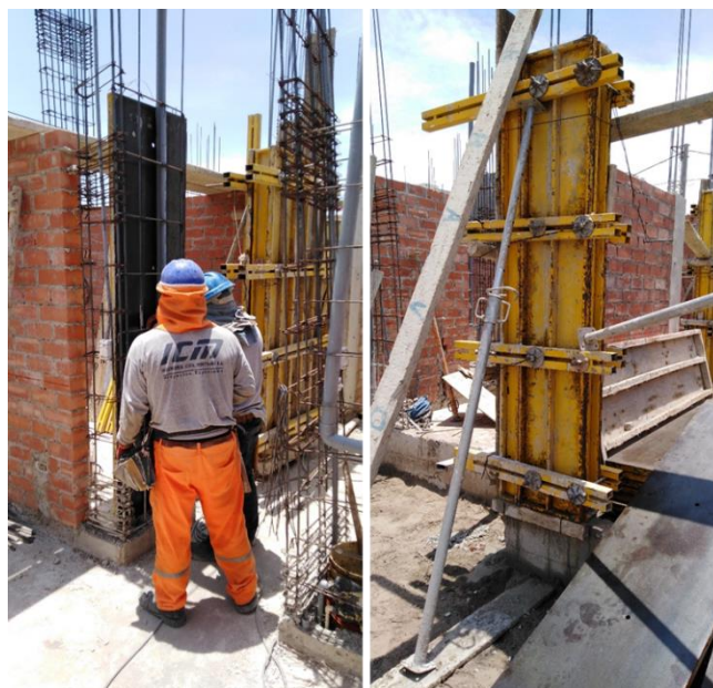
Figura 21: Trabajo Productivo en la partida de Encofrado de Columnas
