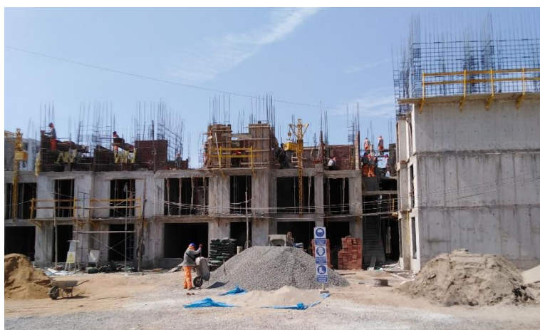
Figura 60: Trabajo Contributorio en la partida de Concreto Muros de corte
