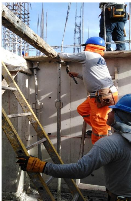
Figura 37: Trabajo Productivo en la partida de Encofrado de Losa.
