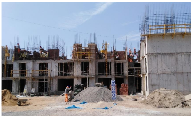
Figura 49: Trabajo Contributorio en la partida de Concreto Columnas
