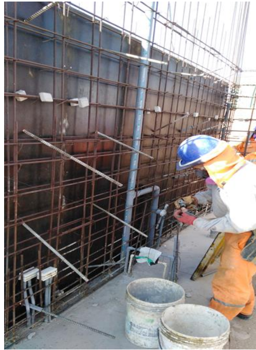
Figura 13: Trabajo Productivo en la Partida de Encofrado Muros de Corte
