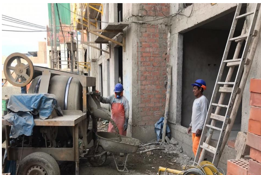
Figura 72: Trabajo Contributorio en la partida de Concreto Losa
