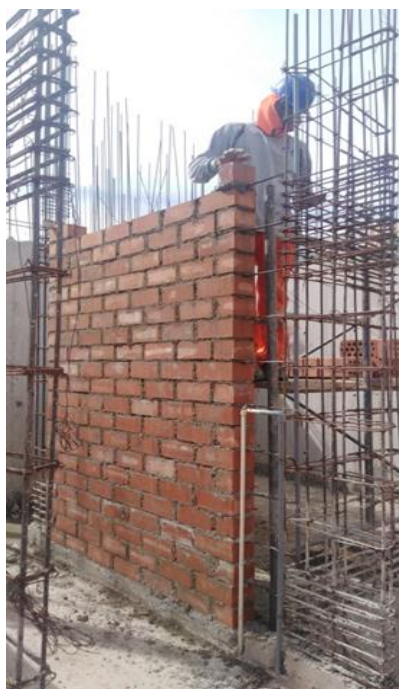
Figura 102: Trabajo Contributorio en la partida de Asentado de Muros de Ladrillo
