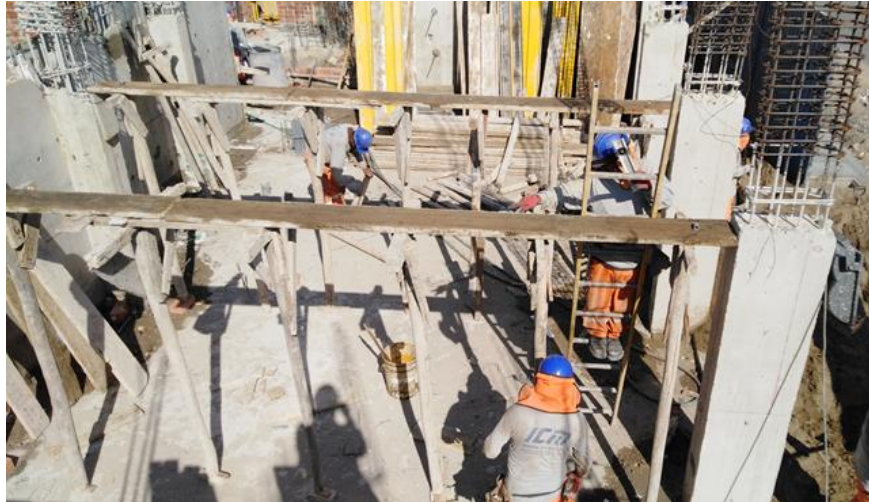
Figura 31: Trabajo Contributorio en la partida de Encofrado de Vigas
