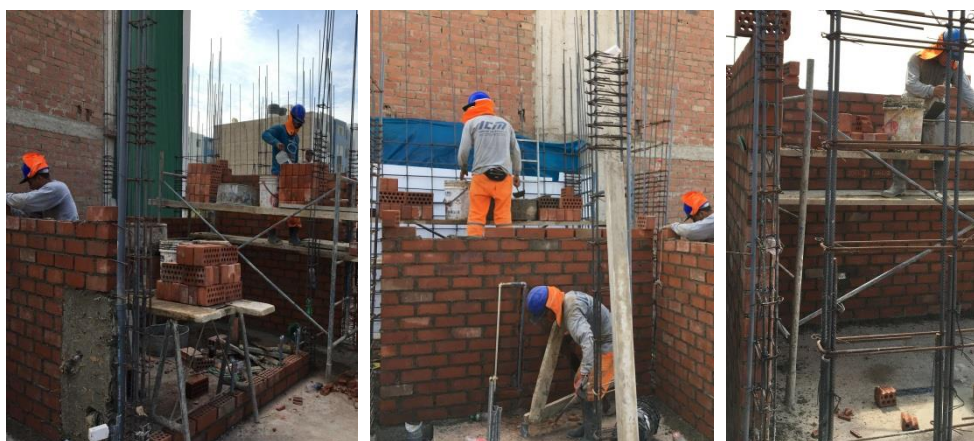
Figura 100: Trabajo Productivo en la Partida de Asentado de Muros Portantes
