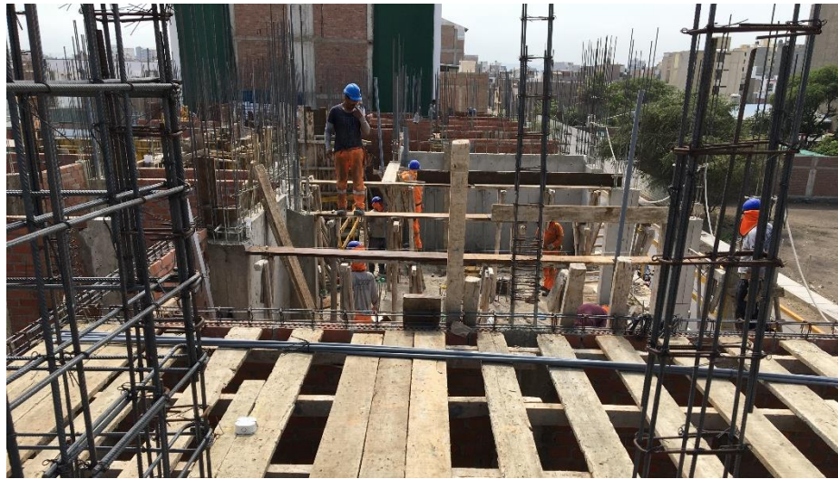
Figura 29: Trabajo Productivo en la Partida de Encofrado de Vigas
