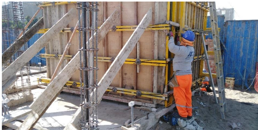
Figura 15: Trabajo Contributorio en la partida de Encofrado Muros de Corte
