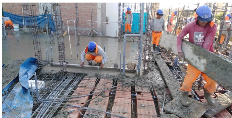
Figura 70: Trabajo Productivo en la partida Concreto Losa
