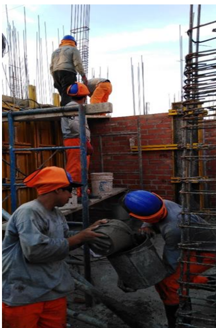
Figura 47: Trabajo Productivo en la partida Concreto Columnas
