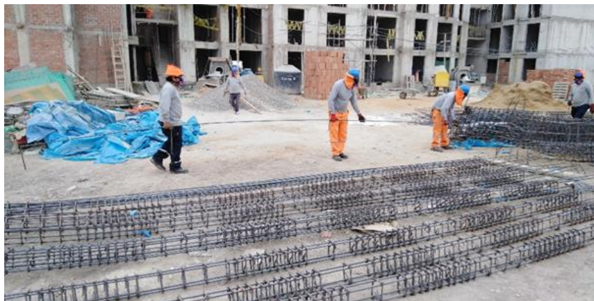
Figura 84: Trabajo Contributorio en la partida de Acero Muros de Corte
