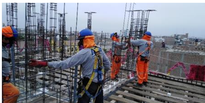
Figura 92: Trabajo Productivo en la partida de Acero Columnas
