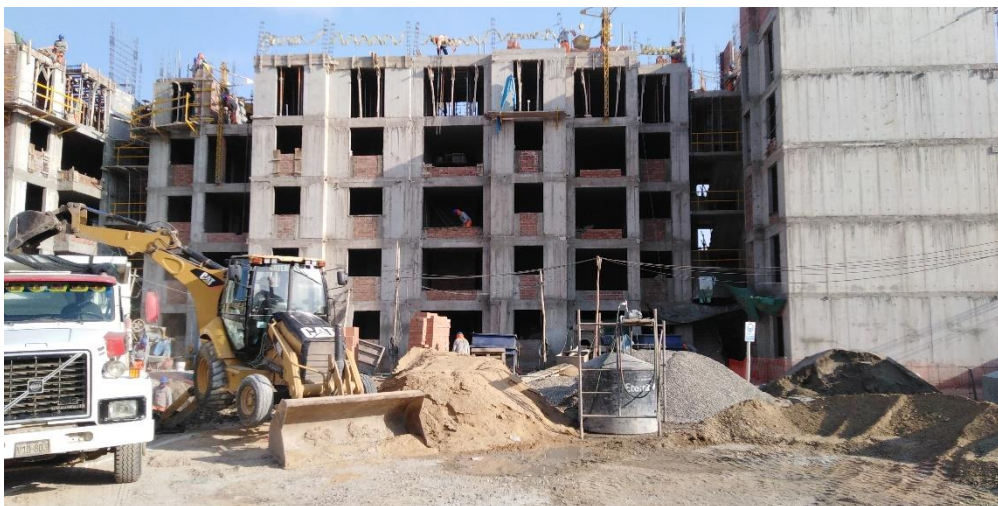
ANEXO N°10: Vista de Fachada terminada de Block A especialidad estructuras
