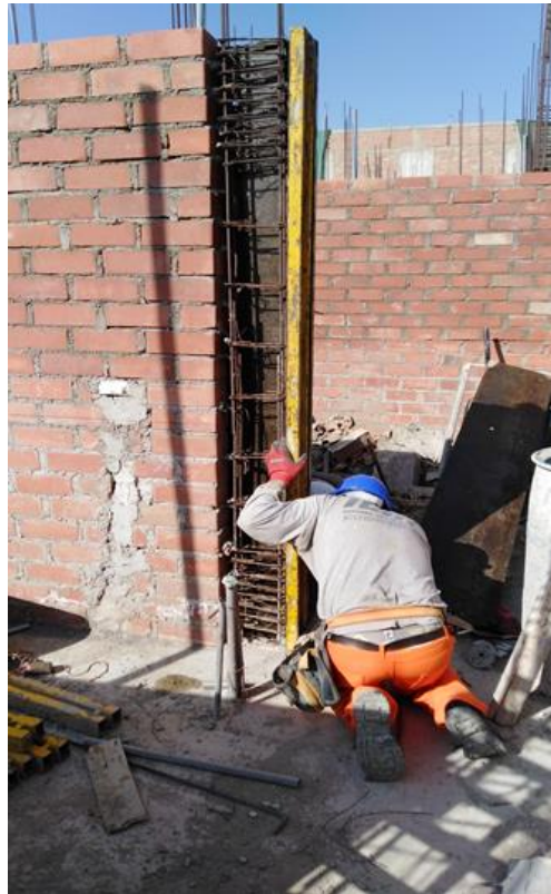
Figura 23: Trabajo Contributorio en la partida de Encofrado d Columnas
