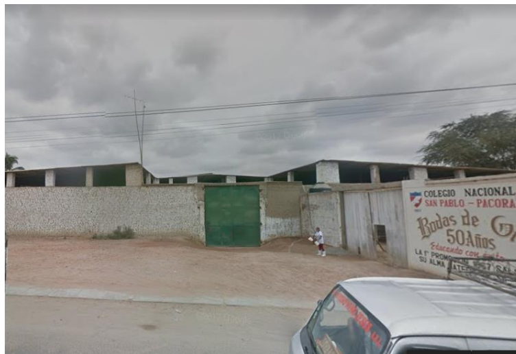
Figura 2 - Fachada de la empresa Alpes Chiclayo S. A. C. Fuente. Google Maps. 2018
