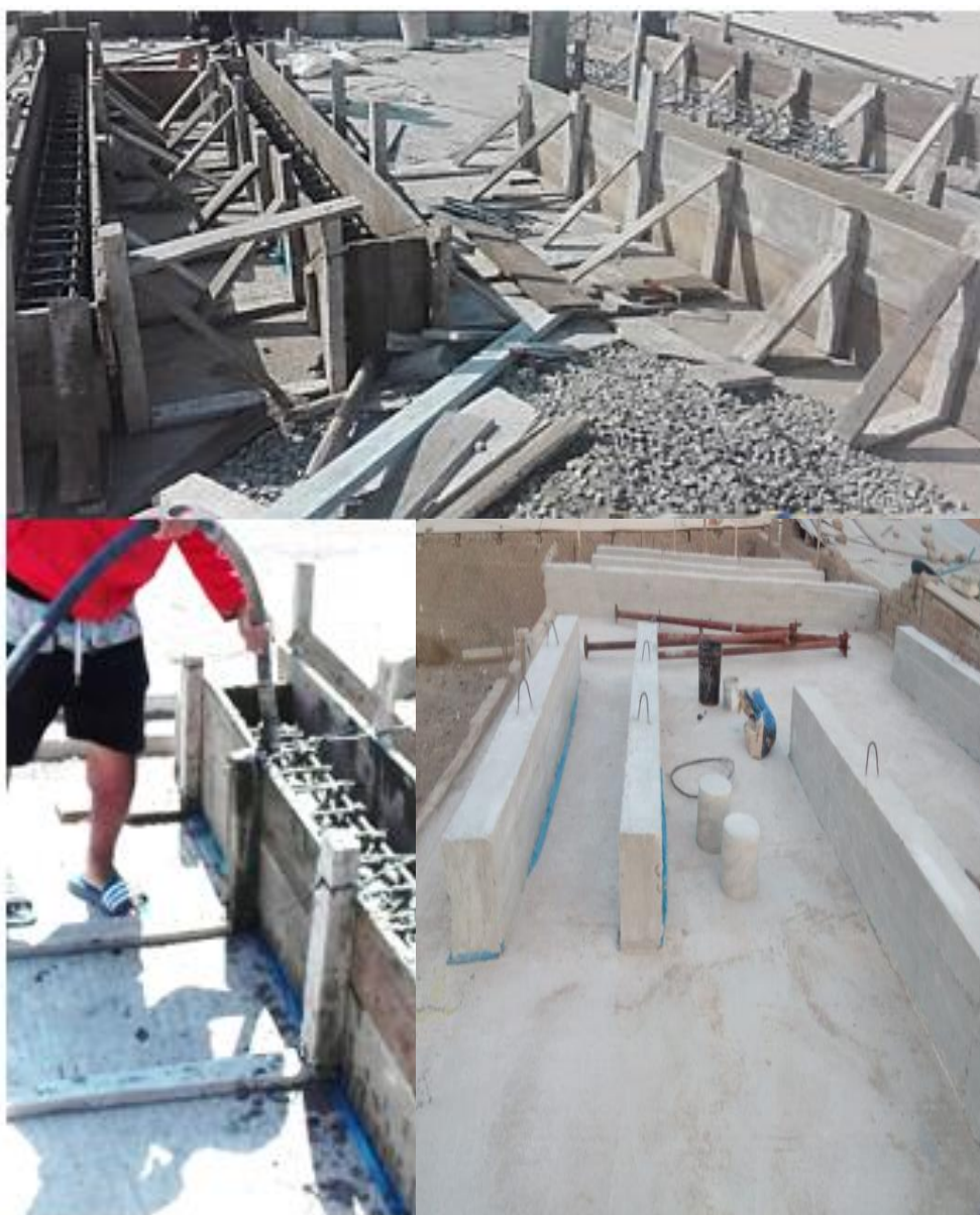
Figura 20. Construcción de vigas
