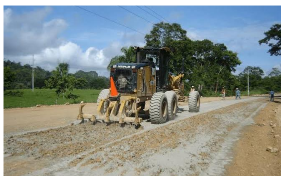
Ilustración N°4. Estabilización con cemento en campo. Fuente: Google
