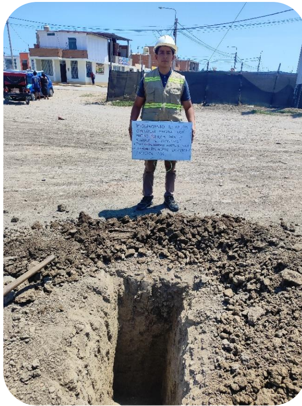
Anexo 05. Extracción de Calicata 01.
