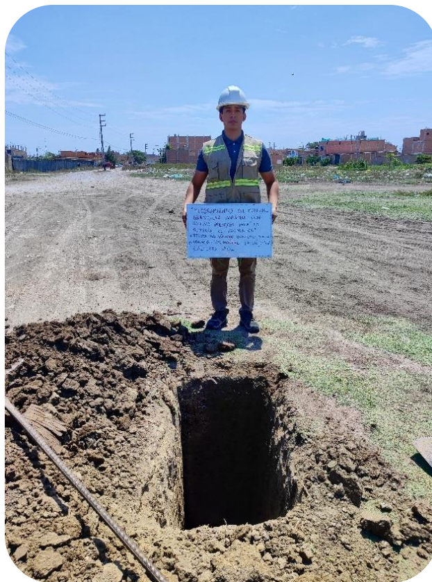
Anexo 06. Extracción de Calicata 02.
