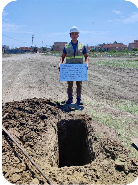
Ilustración 11: Extracción de Calicata 02.
