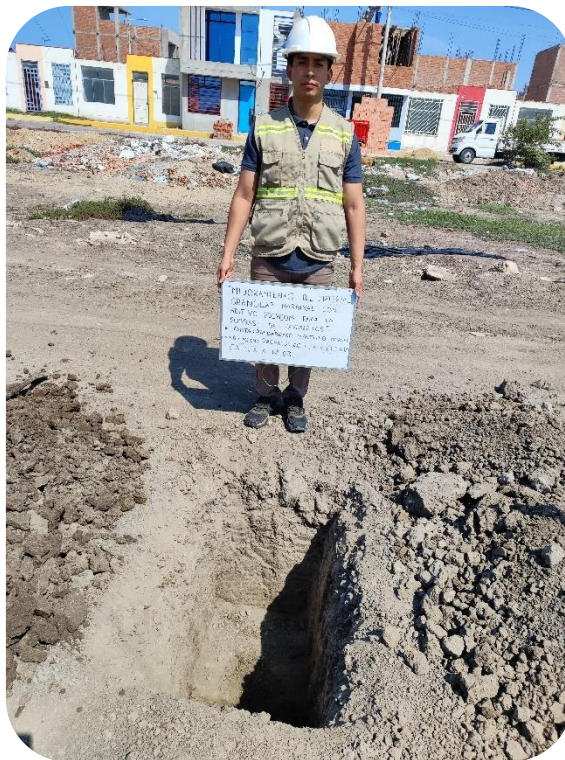
Ilustración 12: Extracción de Calicata 03.
