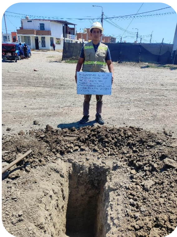
Ilustración 10: Extracción de Calicata 01.
