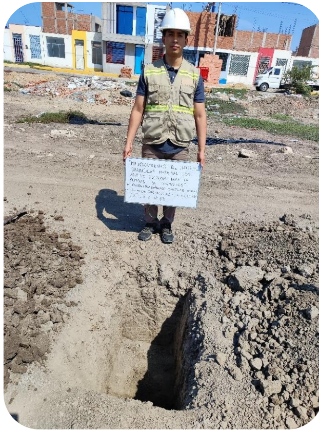
Anexo 07. Extracción de Calicata 03.
